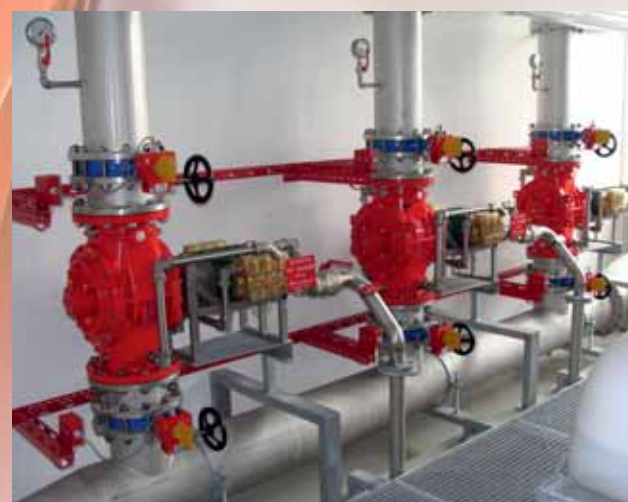
FD8000/3-PP-S в дренажной установке для защиты самолетного ангара
